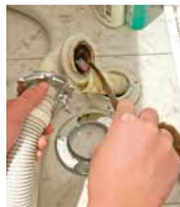
② 排水口の部品を取り外し、ブラシやスポンジ、パイプ洗浄剤、重曹などを使って詰まっているものを取り除く。
