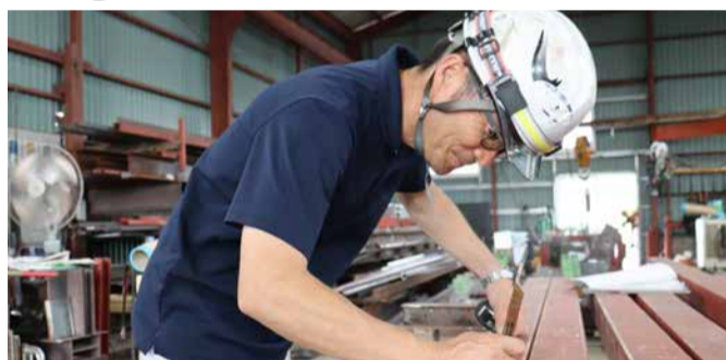
受注内容に合わせて鉄骨の製作を行う様子。
